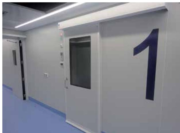
La integración en las estancias de todos los sistemas indicados, además de cámaras de vigilancia y los sofisticados cabeceros médicos, ha supuesto un reto para Montajes Delsaz, con el fin de permitir el paso de las instalaciones eléctricas y de control en el interior de los paneles manteniendo la resistencia mecánica y la estanqueidad de la instalación.
